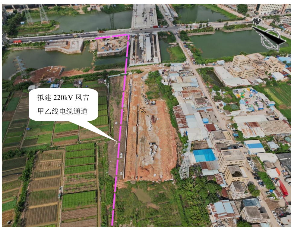
图片 3.2-4 本工程电缆线路终点 (注：本工程电缆线路由南向北敷设)
