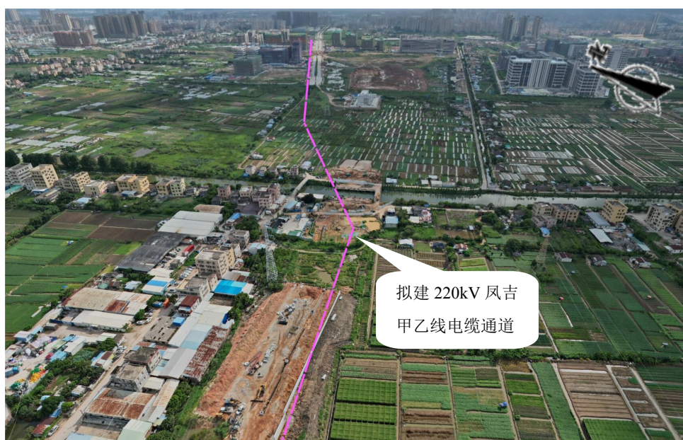
图片 3.2-3 本工程电缆线路中段 (注：本工程电缆线路由南向北敷设)
