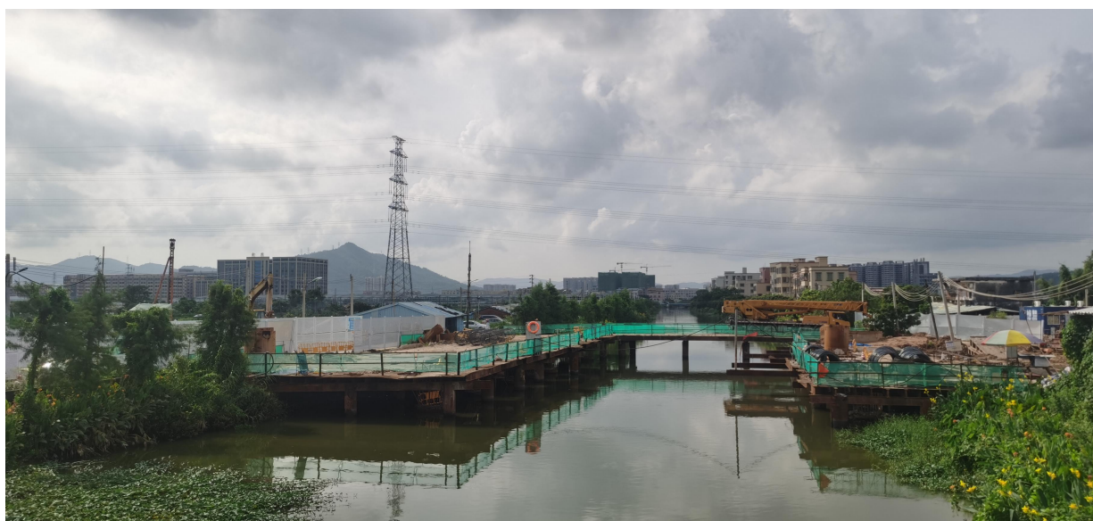
项目过七村涌段
