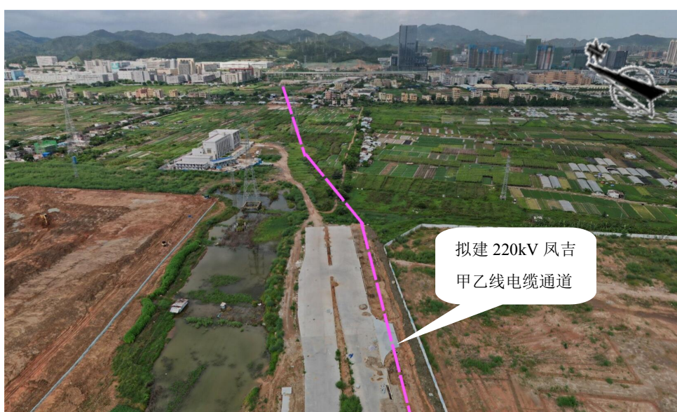
图片 3.2-2 本工程电缆线路中段 (注：本工程电缆线路由南向北敷设)
