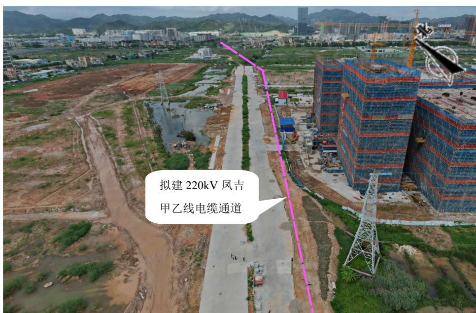
图片 3.2-1 本工程电缆线路起点 (注：本工程电缆线路自南向北敷设)
