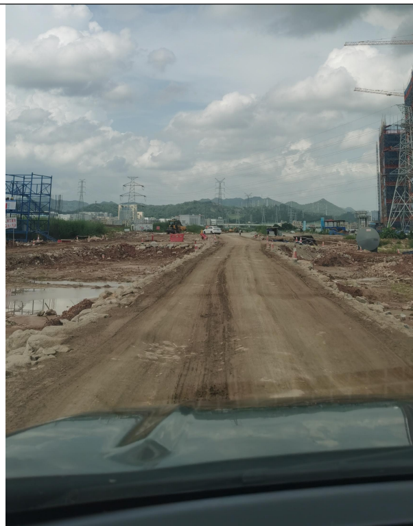
项目建设路段
